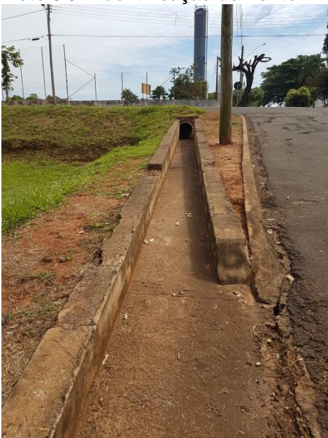
Foto 3.5 – Identificação da estrutura de lançamento próxima ao Ponto P4
