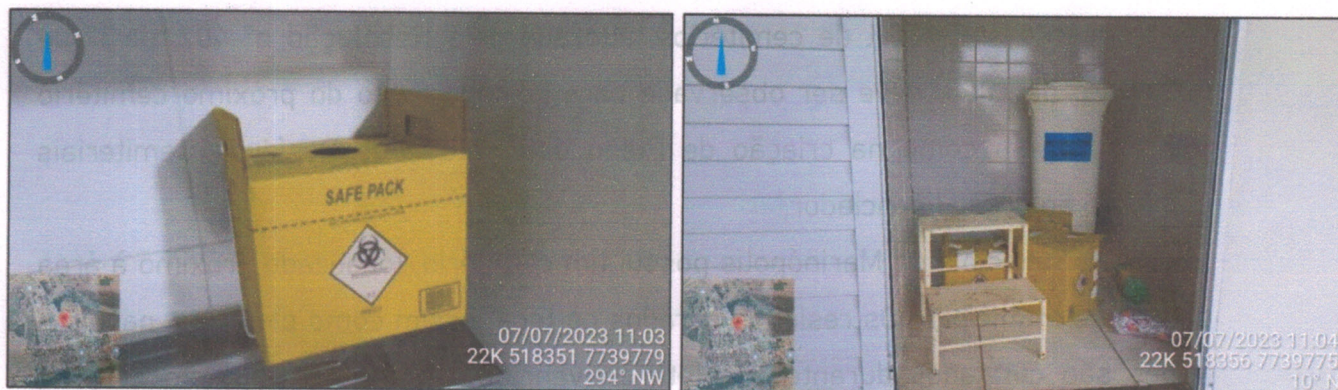
Foto 14 e 15 – Armazenamento de Resíduos de Serviço de Saúde.
