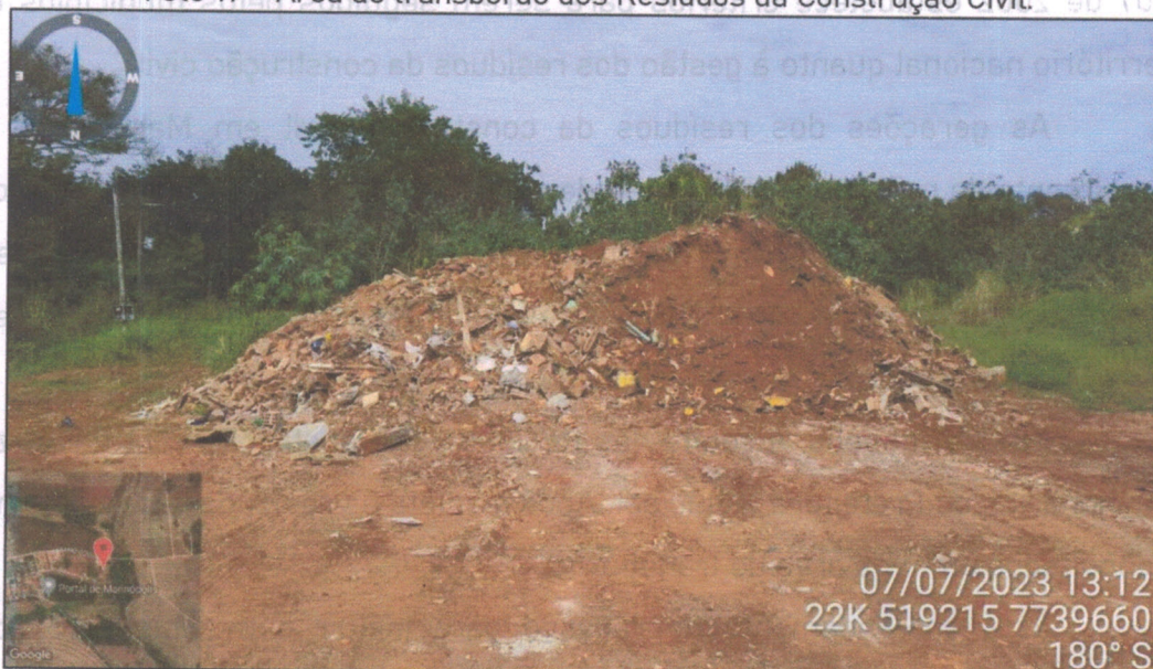
Foto 17 – Área de transbordo dos Resíduos da Construção Civil.
